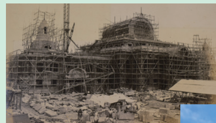
築地本願寺本堂(施工中)
