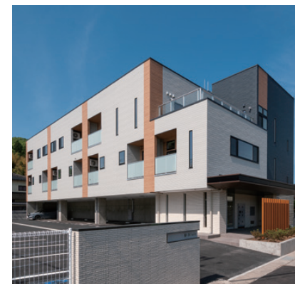
北陸支店森本社宅・寮
