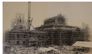
築地本願寺本堂(施工中)
