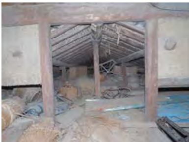
写真3 増築に伴う棟木の延長 (F邸)
