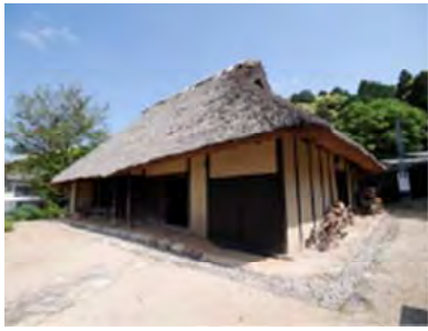
写真1 A邸の外観
