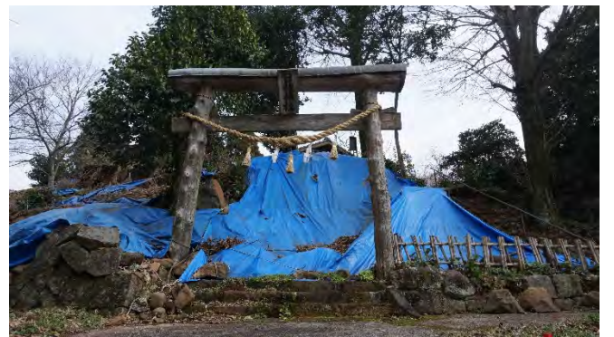
写真 1 拝殿、本殿が全壊したほか参道も大規模に崩落した赤井の日枝神社（2018 年 3 月撮影）
