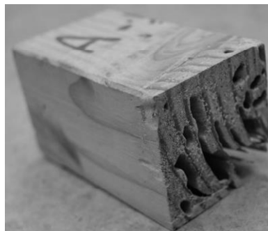
図2 内部のみ劣化した部材
