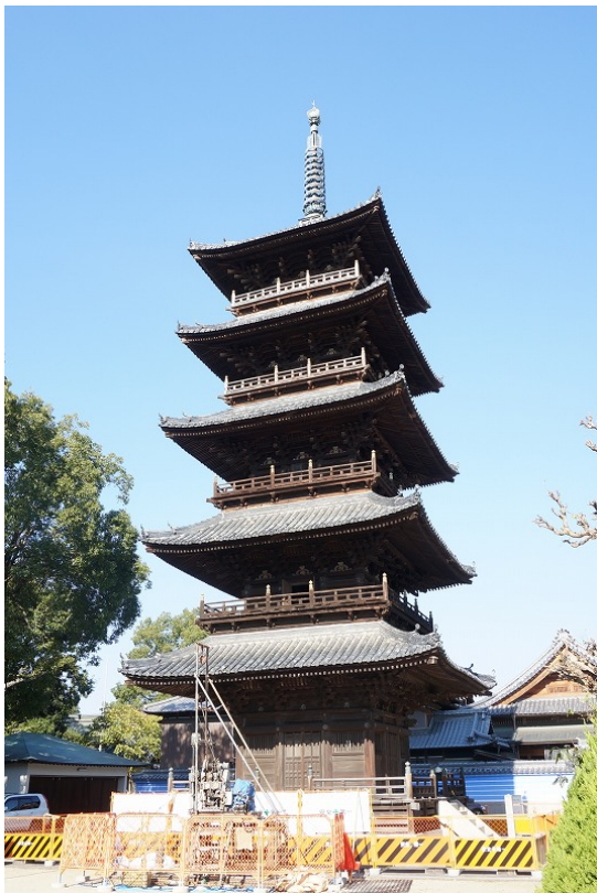
図1 本山寺五重塔の外観 (南側, 2015.11月, 撮影)
