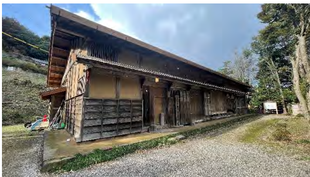
Photo 5 調査対象 E (隠岐の島町)
