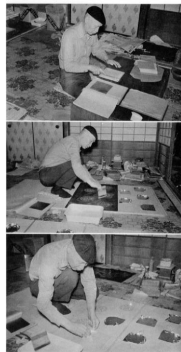
図2-4-3-1 昭和46年の修理の際に文様を摺っている様子(『重要文化財成巽閣及び辰巳長屋修理工事報告書』より転載)
