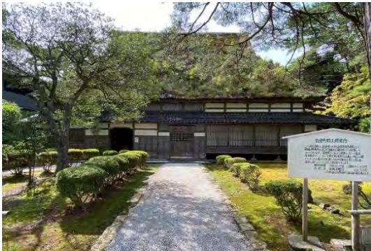
写真1. 郷土館、現状正面外観
